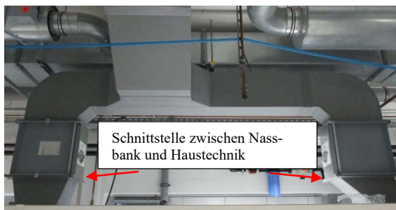
Abb. 2: Bild der Schnittstelle zwischen Nassbank und Haustechnik
